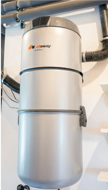
Im Vergleich zu herkömmlichen, konventionellen Staubsaugern wird die Luft beim Saugen nicht wieder in den Raum geblasen, sondern effizient und nahezu rückstandsfrei an die Außenluft abgegeben. Das Ergebnis ist eine besonders reine und gesunde Innenraumluft. Zusätzliche Aspekte, die Familie Wohlfromm überzeugten, sind die **besonders geringe Geräuschkentwicklung** beim Saugvorgang, das **kinderleichte Handling** und die **moderaten Anschaffungskosten**, die den hohen Mehrwert rechtfertigen.
