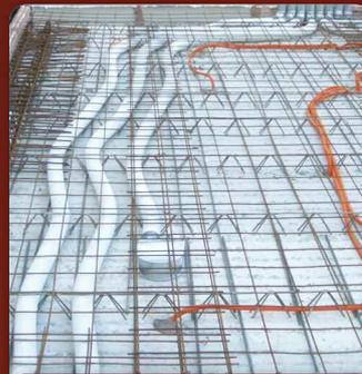
Für jede Verlegeart die passende Lösung. FlexPipe®<sup>plus</sup> kombiniert das bewährte Rundrohrkonzept mit ovalen Komponenten. In beliebiger Form, für noch mehr Flexibilität bei Planung und Installation. RenoPipe ist die perfekte Lösung für die energetische Sanierung und wird einfach aufputz an Decke oder Wand installiert. In flacher Bauart und steifer Konstruktion stehen ferner Flachkanal-Systeme aus verzinktem Stahlblech oder Kunststoff zur Verfügung.
