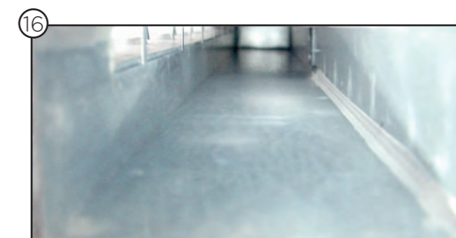
Kanalstrecke nach der Reinigung
