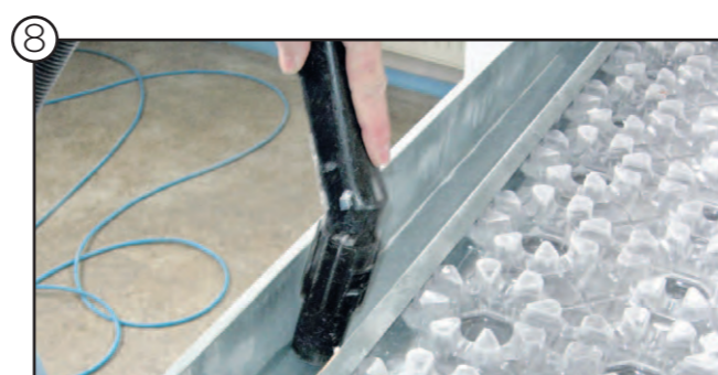
Reinigung des Luftauslasses mit einem Industriestaubsauger
