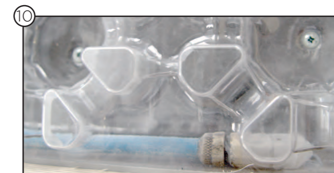
Die Pressluftdüse wird durch das System geschoben, um die Verunreinigung zu lösen
