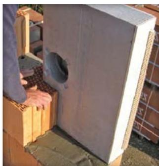
Das LUNOtherm A60 lässt sich im Neubau auch gut in das Mauerwerk einpassen. Die Mauersteine werden entsprechend ausgespart.
