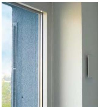
Das Aussengitter kann – je nach Fassadenfarbe – entsprechend angepasst werden. Es ist überstreichbar und lässt sich somit nahezu perfekt integrieren.
