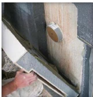
Das LUNOtherm lässt sich mit den verschiedensten Fassadensystemen verarbeiten: dünn- oder dickschichtige Putzsysteme, hinterlüftete Fassaden oder auch mit einem Blendmauerwerk.
